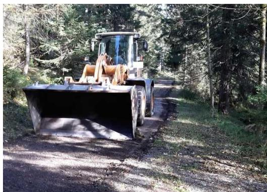
**Mittwoch, 16.10.2019:** Schweres Gerät/Caterpillar rückt an, um den Forstweg unserer Rodelbahn einzuebnen. Die Fahrspuren werden ausgeglichen und die Wasserrinnen wieder instand gesetzt. Eine wichtige Arbeit, die sich bei einer 1.280 Meter langen Rodelbahn in die Länge zieht.
